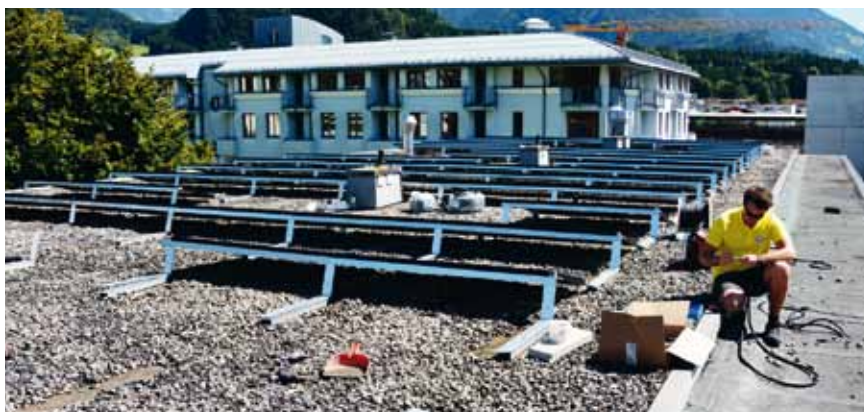
Photovoltaikanlage der Caritas auf dem Dach der Werkstatt in Bludenz deckt ein Viertel des Energiebedarfs der Kantine ab.
